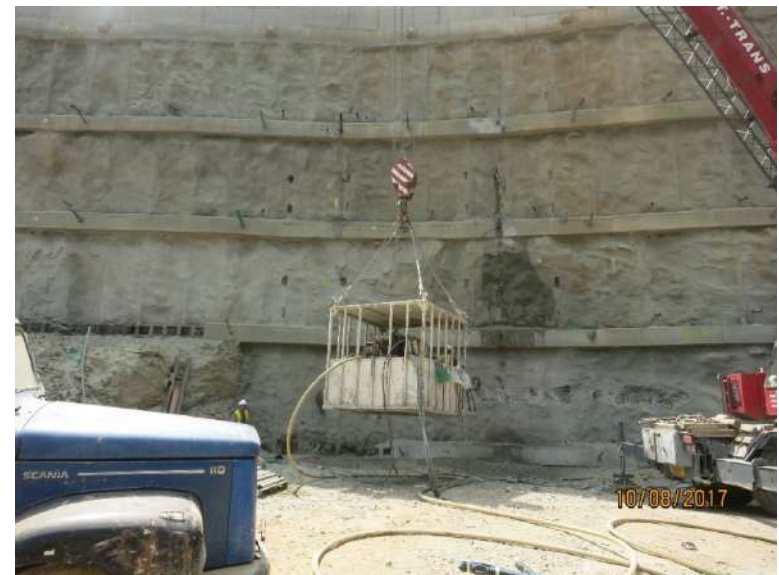
Bušenje dodatnih ankera na već izvedenoj kosini, gde je jedini mogući način izvođenja uz pomoć tzv. „korpe“ koja se podiže pomoću kрана (Grdelička klisura)
