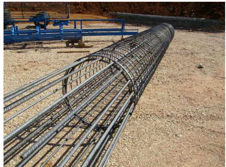
Armatura za bušeni šip, tzv. armaturni koš (E80, Dimitrovgrad)
