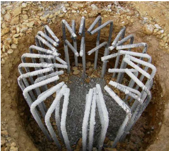
Bušeni šip izveden u tlu – armaturni koš je postavljen u bušotinu i naknadno zaliven betonom (Dimitrovgrad)
