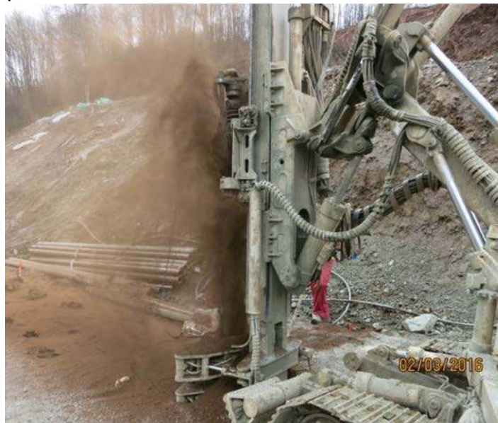
Garnitura za bušenje kombinovanim postupkom bez jezgrovanja (kao isplaka se koristi komprimovani vazduh)(levo) i izgled šipova malog prečnika (mikrošipova) u sklopu kosine, sa prednapregnutim kablovskim ankerima u zoni naglavne grede (Grdelica)
