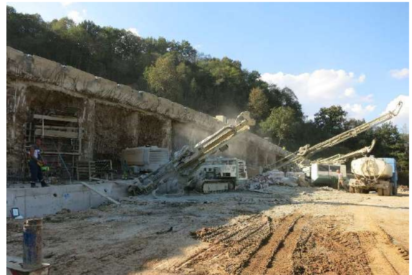
Tri garniture koje istovremeno izводе duboke bušotine pod uglom za prednapregnuta sidra u zoni potporne konstrukcije od šipova (Predejane, Grdelica)
