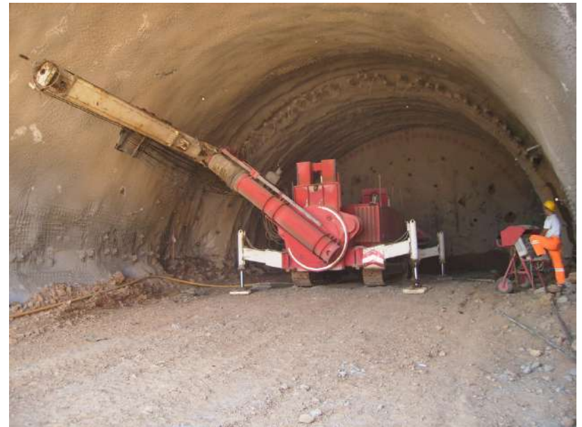
Bušenje „Bumerom“ za postavljanje cevnog štita u tunelu Progon kod Dimitrovgrada
