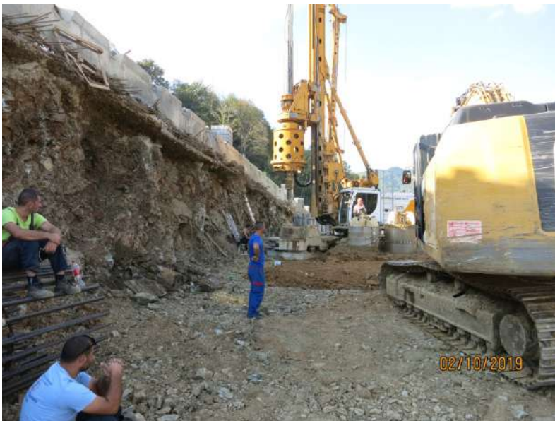
Garnitura za izvođenje šipova i izvedena potporna konstrukcija od šipova (Predejane)
