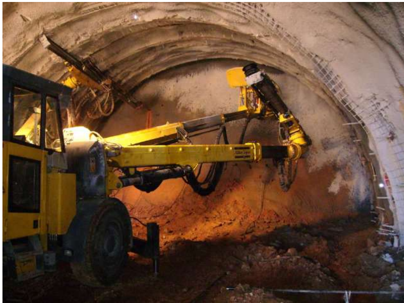
Mašina sa tri radne ruke vrši bušenje za postavljanje ankera na čelu tunela Progon (koristi se i za bušenje minskih bušotina)
